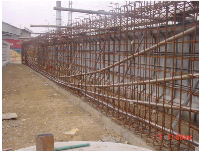
Figura 3-19 Viga postensada de puente en construcción. Fuente: Propia.
