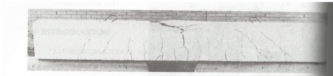
Figura 3-6. Fisuras de flexión en la zona de tensión y de aplastamiento en la zona de compresión de una viga simplemente apoyada experimentada por (Nawy, 1998)
