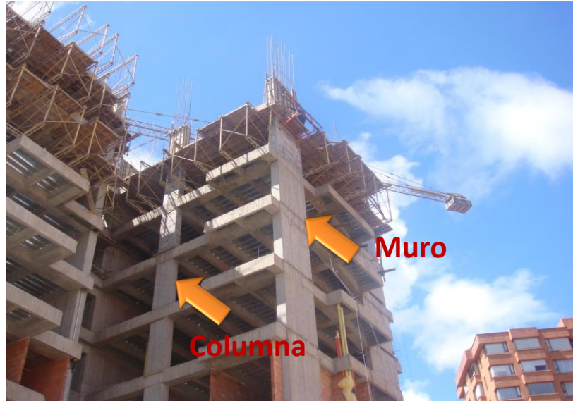
Figura 3 - 38 . Edificio de concreto en construcción. Identificación de un muro y una columna. Fuente: (Sandra Suarez, 2010)
