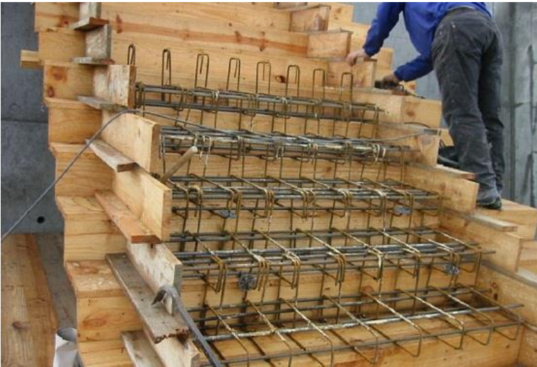
Figura 3 - 76 Escalera de una sola línea. Fuente: Tomado Diseño de escaleras de concreto.
