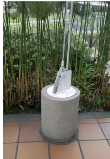
Figura 3 - 41 Ejemplo de pedestal que sirve de anclaje de cable cubierta. Fuente: (Sandra Suarez, 2010)
