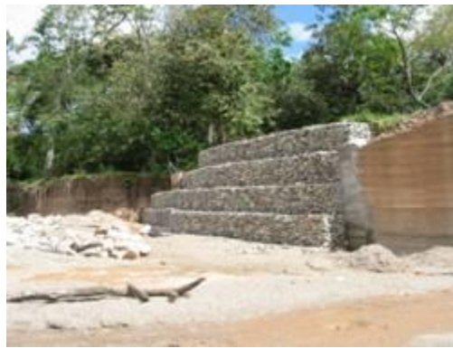
Figura 3 - 50. Gaviones para protección de aletas y estribo. Fuente:(E. Muñoz, 2011)
