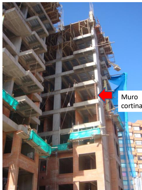
Figura 3 - 66 Muro cortina en edificio en construcción.
