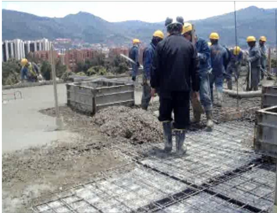
Figura 4-24 Fundida del concreto del entrepiso
