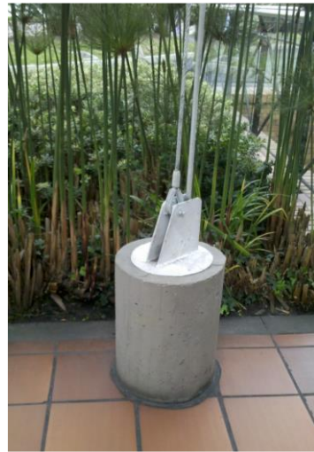
Figura 4-68 Ejemplo de pedestal que sirve de anclaje de cable cubierta. Fuente: Suarez - 2013 [1].
