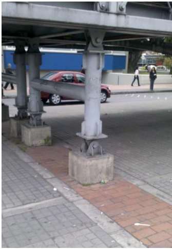
Figura 4-67 Ejemplo de pedestal que soporta pila de acero de puentes peatonal. Fuente: Suarez - 2013 [1].
