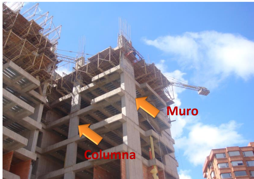
Figura 4-65. Edificio de concreto en construcción. Identificación de un muro y una columna. Fuente: Suarez - 2013 [1].
