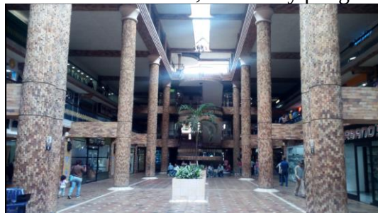
Figura 4-71 Fotos de columnas largas. Fuente: GPT-4
