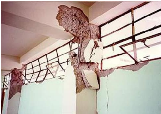
Figura 4-69 Identificación de una columna corta y otra esbelta en un pórtico plano.
