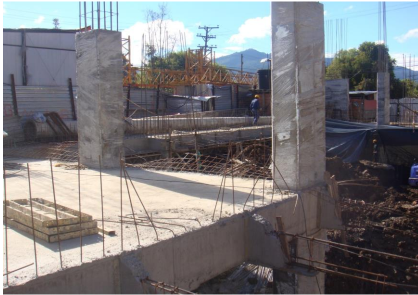
Figura 4-103 Curado de una columna
